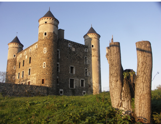
Le château de Bon Repos (38) classé au titre des monuments historiques a concilié préservation du patrimoine historique et protection des oiseaux
